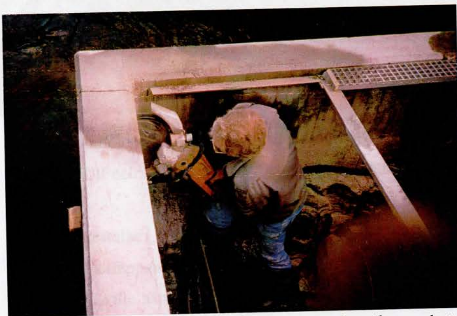
Här sågas upp ett större hål i den gamla fisketrappan med diamantsåg. Stig Norberg
